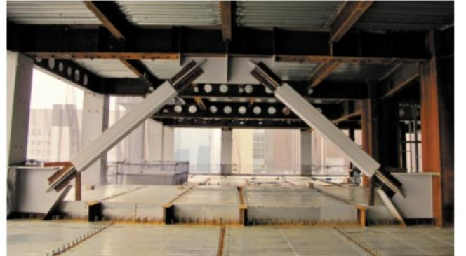
图10 耗能减震支撑
