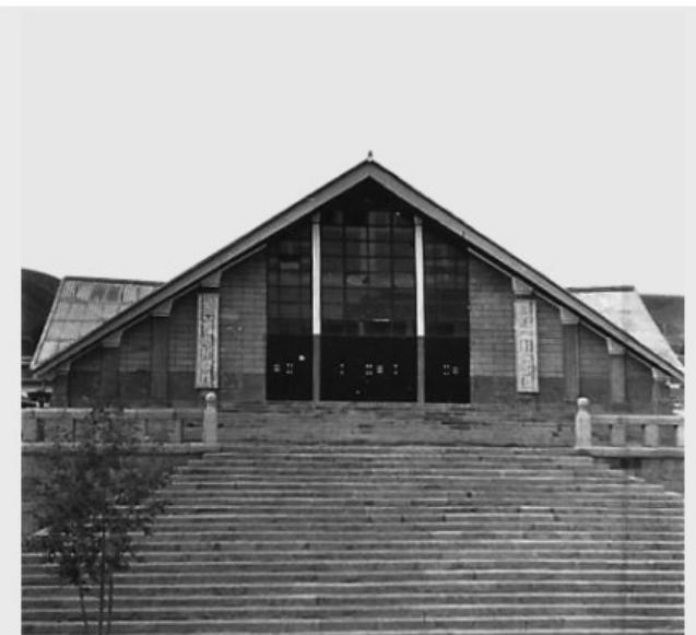
结构抗震设计的基础上，徐总提出了县礼堂采用“落地三铰拱”方案，解决了高烈度地区大空间木结构的抗震问题。经赴中科院工力所调研和学习有关材料，这一方案成功实施。
