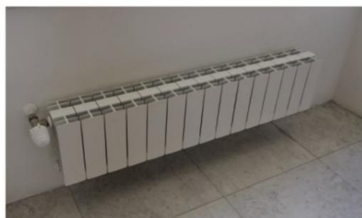
▲ 窗台边设置的散热器（钢制散热器、散热器温控阀）
