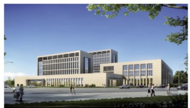
项目位于成都市青白江区东南侧，通汇大道与香岛大道交叉口，用地面积41999.53平方米，规划总建筑面积62499.9平方米，其中地上建筑面积54160平方米，为4层钢结构建筑，地下建筑面积8339.9平方米，为地下停车场；建筑主要功能包括平行进口车展示展销中心、政务大厅及车辆登记中心、办公用房等配套设施。
